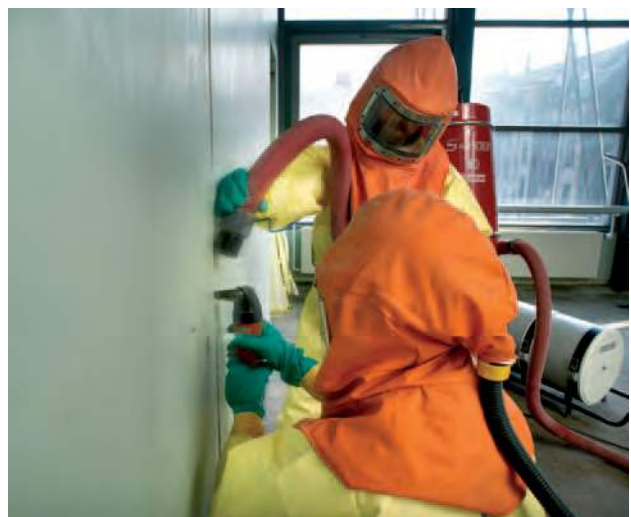
Sanering af indvendige fuger
