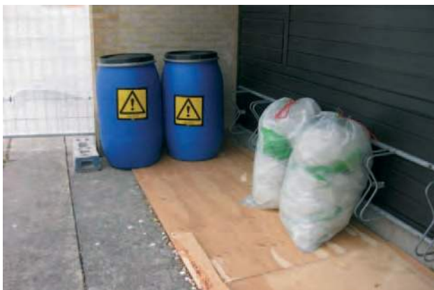
Eksempel på opbevaring af PCB-holdigt affald
