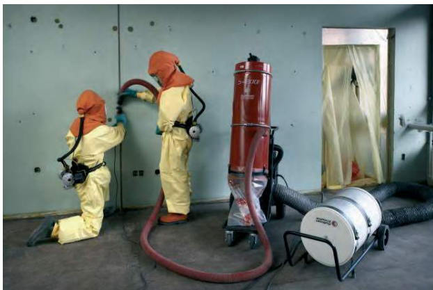
Eksempel på PCB-støvsuger med PCB-filtre
